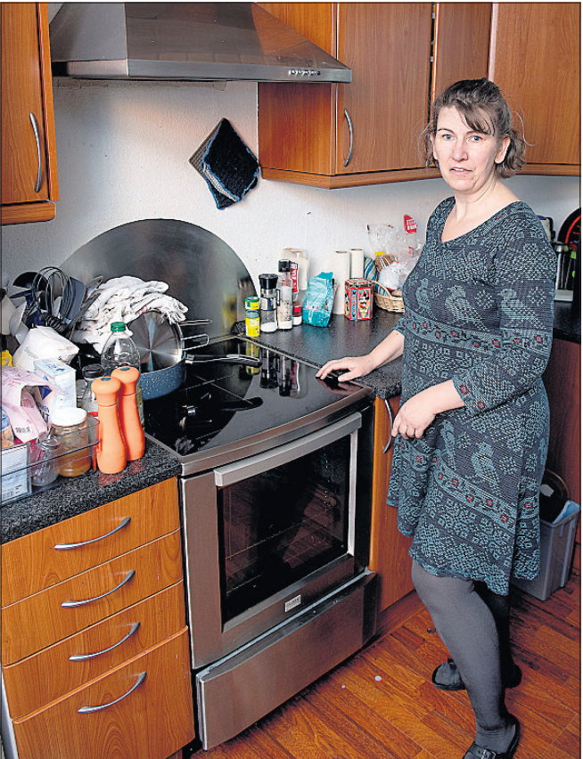
Der er overgang i hvidevarerne, så man får stød, hvis man rører ved komfur og emhætte på samme tid, fortæller Tinna Andersen.
