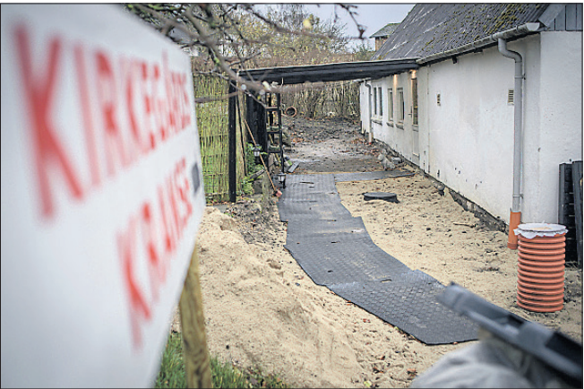
I oktober blev indkørslen gravet op og ny kloakker lagt ned.
