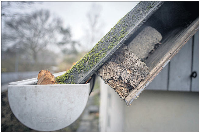
Den gamle tagkonstruktion har mange åbninger.
